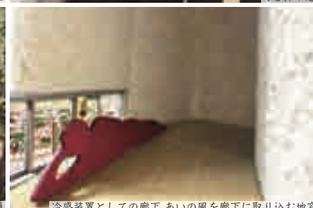
冷感装置としての廊下 あいの風を廊下に取り込む地窓
