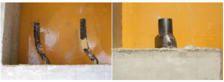
接合部材の変形
